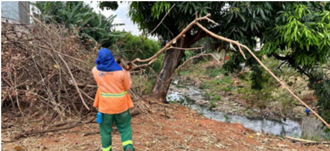
Reforço de roçagem e retirada de lixo para melhor escoamento das águas das chuvas
